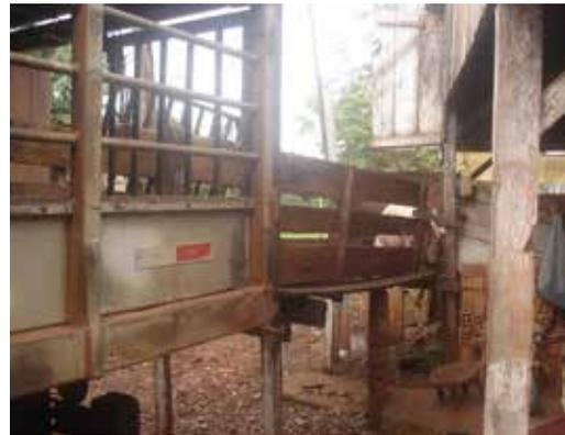
Figura 17. Embarcadouro com paredes vazadas provoca distrações
