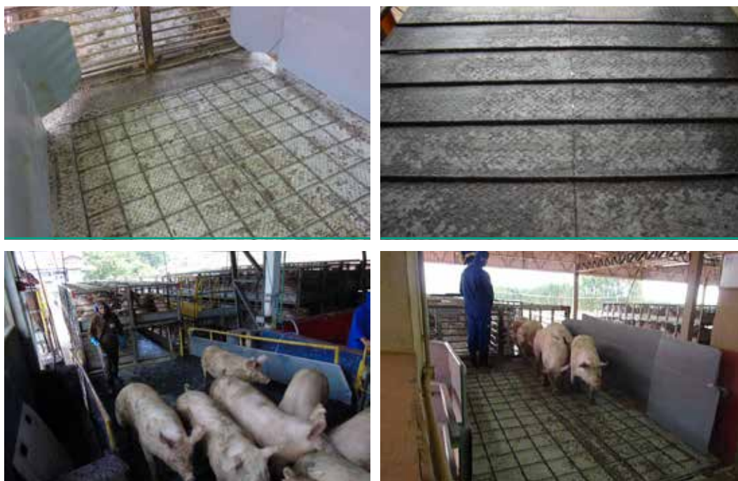
Figura 2. Rampas com piso antiderrapante (metálico riscado xadrez, com grades no piso, emborrachado) e angulação adequada.
