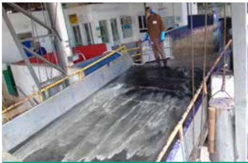
Figura 3. Limpeza da rampa evita escorregões e quedas.
