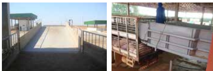
Figura 1. Rampa de desembarque longa, com estrutura metálica, móvel e com paredes laterais fechadas, facilita a retirada dos suínos sem ocorrência de quedas e escorregões.
